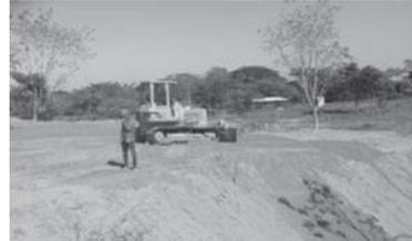
Foto No. 12. Caño Arenas. Lado Seco. Extensión material de descapote
