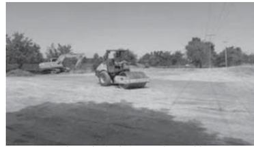
Foto No. 08. Caño Tabaco. Lado Húmedo. Compactación material de cantera
