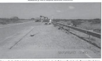
Fotografía No 5.50 Actividades de mantenimiento de vía Calamar Santa Lucía. Excavación de base existente y retiro carpeta asfáltica existente.
