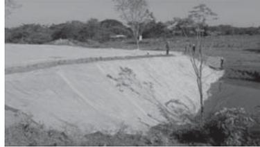
Foto No. 15. Caño Arenas. Lado Seco. Manto temporal para control de erosión
