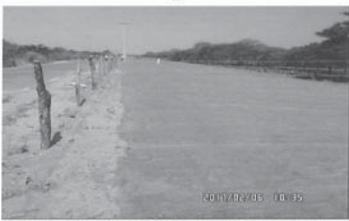
Fotografía No 5.52 Avance conformación de relleno con material de cantera predio 41.
