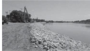
Foto No. 23. Boquitas. Capa de piedra colocada y extendida
