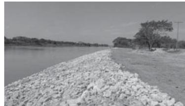
Foto No. 24. Boquitas. Capa de piedra colocada y extendida
