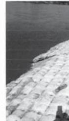
Foto No. 11. Protección de talud después de presentar niveles bajos de caudal (4,85m). Se presenta descosido de módulos de formaleta y parte de no llenado de la formaleta.
