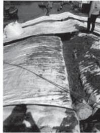
Foto No. 06. Preparación de formaleta textil para Fundida en la Abscisa KB+750.
