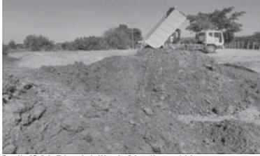
Foto No. 05. Caño Tabaco. Lado Húmedo. Colocación material de cantera
