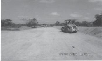
Fotografía No 5.48 Avance conformación de relleno con material de cantera predio 41.
