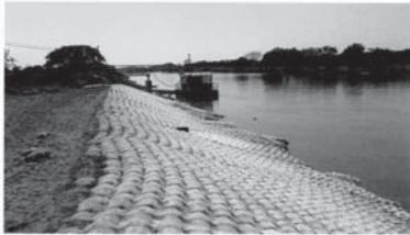
Foto No. 14. Estado actual de protección de talud de colchacetro después de presentar niveles bajos de caudal (4,85m).
