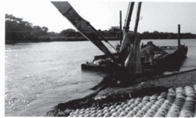
Foto No. 01. Retiro de formaleta textil colchacetro por no cumplir técnicamente, ya que quedaron mal fundidas desde la abscisa KB+750, numero de módulos 7.
