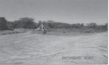
Fotografía No 5.34 Actividades de mantenimiento de vía Calamar Santa Lucía. Retiro carpeta asfáltica y material de base existente.
