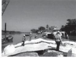
Foto No. 05. Preparación de formaleta textil para Fundida en la Abscisa KB+750.
