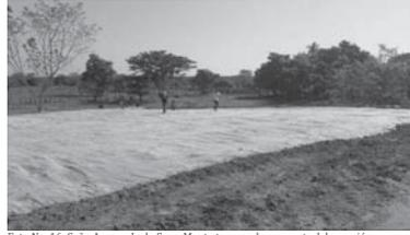
Foto No. 16. Caño Arenas. Lado Seco. Manto temporal para control de erosión
