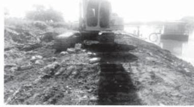
Foto No. 02. Retiro de formaleta textil colchacetro por no cumplir técnicamente, ya que quedaron mal fundidas desde la abscisa KB+750, numero de módulos 7.
