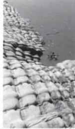
Foto No. 13. Estado actual de protección de talud de colchacetro después de presentar niveles bajos de caudal (4,85m).
