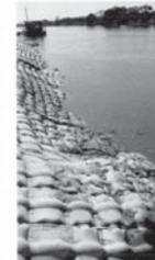
Foto No. 12. Estado actual de protección de talud de colchacreto después de presentar niveles bajos de caudal (4,85m).
