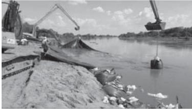
Foto No. 21. Boquitas. Colocación geotextil tejido
