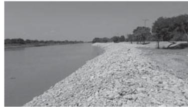
Foto No. 27: Capa de piedra colocada y extendida
