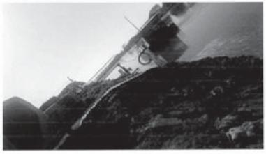
Foto No. 03. Retiro de formaleta textil colchacetro por no cumplir técnicamente, ya que quedaron mal fundidas desde la abscisa KB+750, numero de módulos 7.
