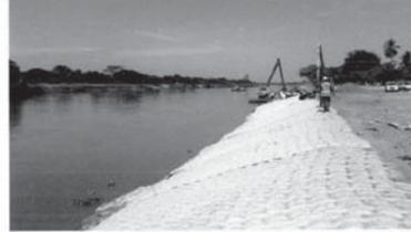
Foto No. 15. Estado actual de protección de talud de colchacetro después de presentar niveles bajos de caudal (4,85m).
