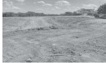
Foto No. 07. Caño Tabaco. Lado Húmedo. Conformación material de cantera
