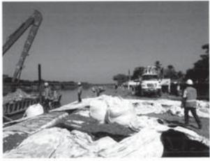
Foto No. 04. Colocación de bolsas big bag en tramo a fundir a partir de la abscisa KB+750.
