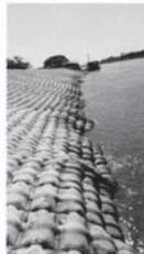
Foto No. 10. Estado actual de protección de talud de colchacreto después de presentar niveles bajos de caudal (4,85m).
