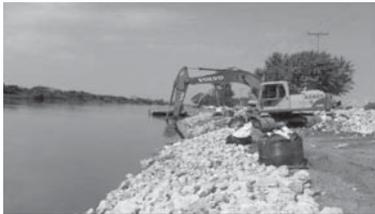
Foto No. 22. Boquitas. Colocación de capa de piedra
